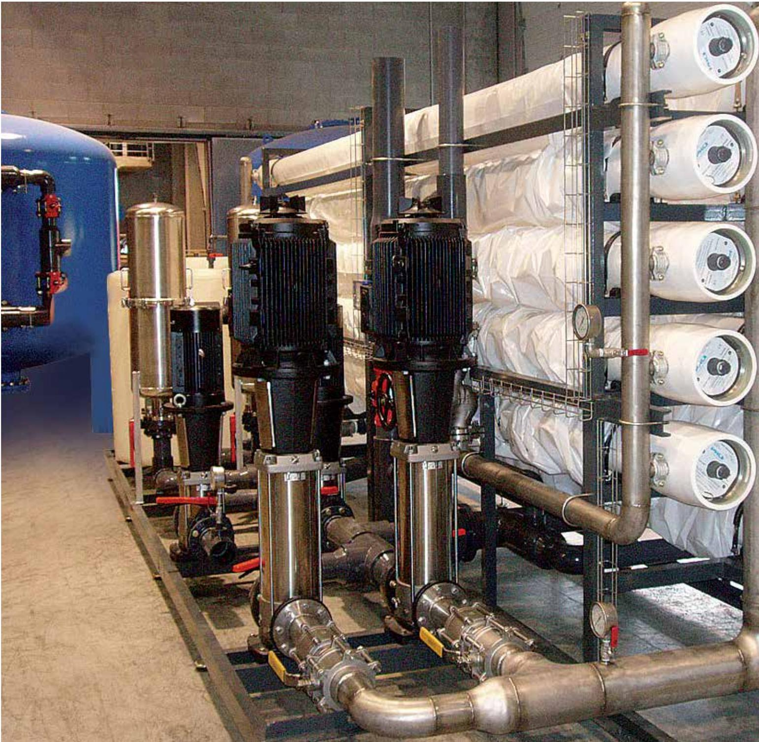
Planta de ósmosis de doble paso para producción de agua de alta calidad para lavado de automóviles.
