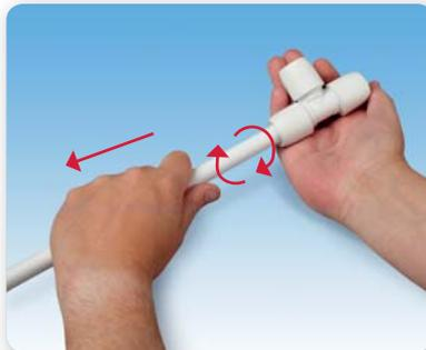
**4.** Gira el tubo dentro del accesorio para “sentir” que la tubería está correctamente instalada. Tira de la tubería para asegurar la fijación del retenedor.
