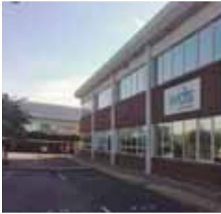
Modernización de Call Center. Woodhouse Environmental Services Ltd. Bourmemouth, Reino Unido. VRF
