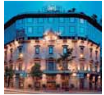
Reacondicionamiento de hotel. Hotel Claris 5 *. Barcelona, España. ECOi
