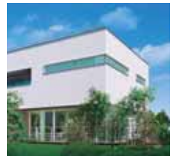
Casa inteligente. Ariake, Tokio. Climatizador combinado con generación fotovoltaica, pilas de combustible y baterías.
