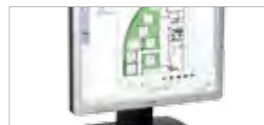
SISTEMAS DE GESTIÓN Y CONTROL CENTRALIZADO
